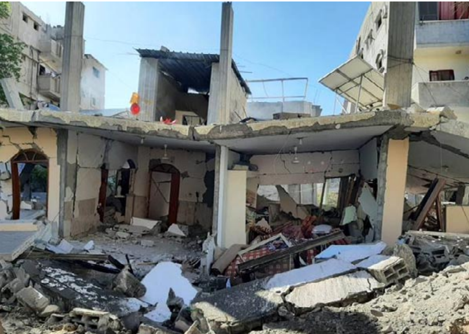
Zerstörtes Haus in Gaza, Foto: ©Pax Christi Deutschland
